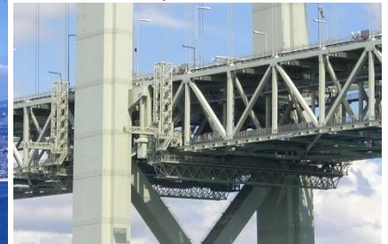
橋桁を点検・補修する作業車
