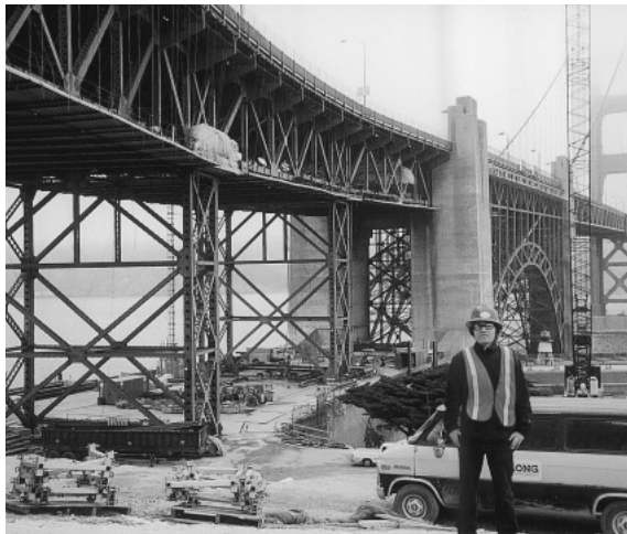
■ゴールデンゲートブリッジ耐震補強工事現場にて
