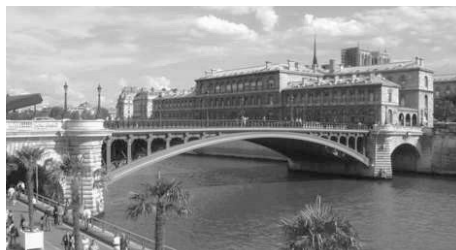
■パリ・ノートルダム橋
