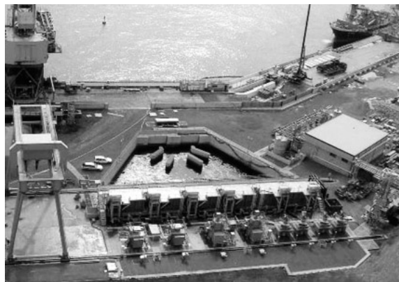
■神鋼神戸発電所海水ポンプピット 全景
