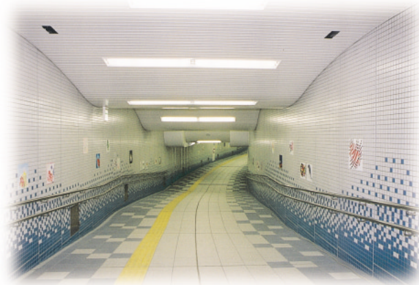
■協働の駅舎づくりの一環として海の生き物絵タイル (海の中をイメージした駒ヶ林駅連絡通路に設置した)
