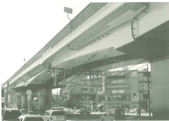
■喜連瓜破高架橋補強工事完成状況
