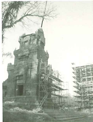
■JSAによる修復現場
