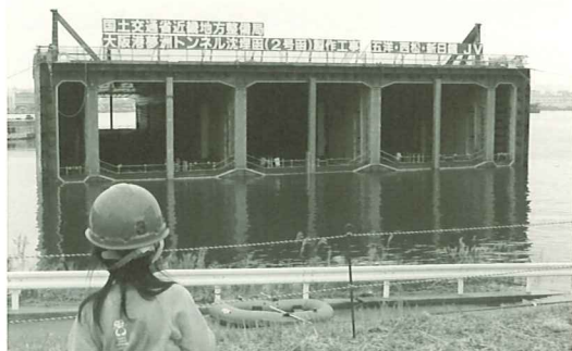
■5000トンの沈埋函が浮いています
