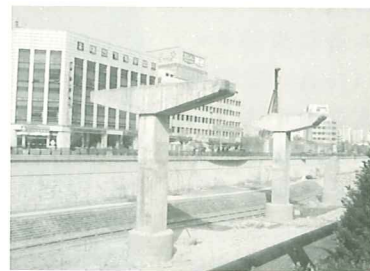
■撤去された高架橋の一部は、そのまま残される
