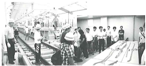
■京阪電鉄淀駅高架化工事の現場とプラレールを使った説明
