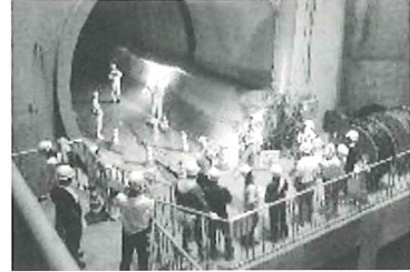
■「いろは呑龍トンネル」の内部
