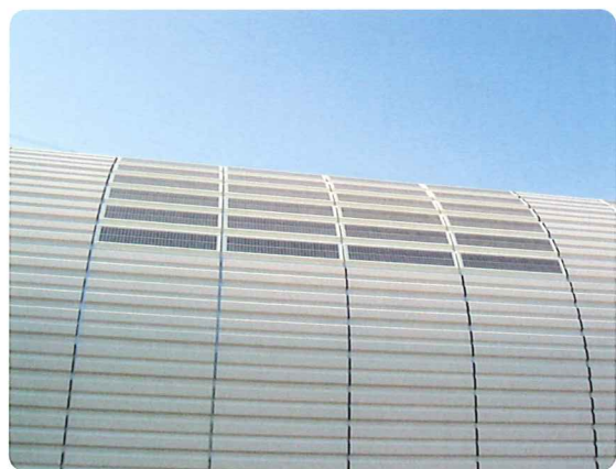
■遮音壁一体型太陽光パネル
