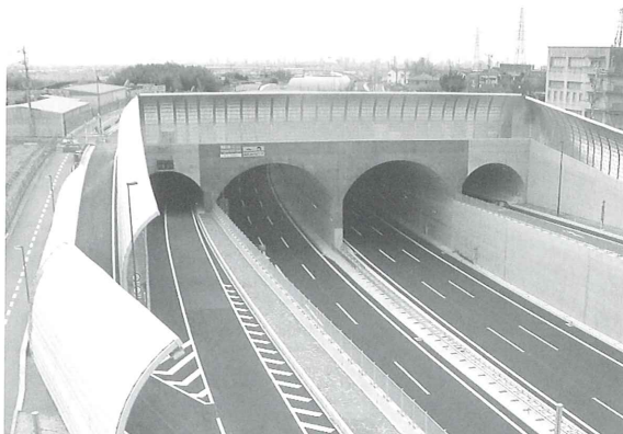
■4連アーチカルバート完成写真(起点側より)
