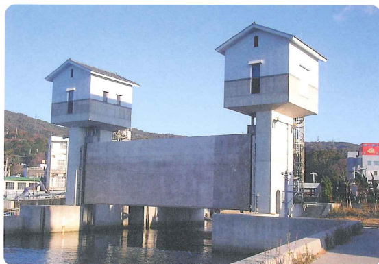
■津波警報により自動閉鎖する水門
