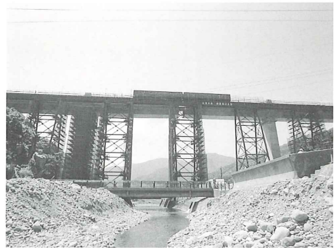
■完成直前の余部橋りょう
