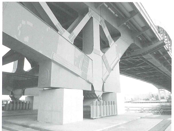
■耐震補強工事が完成した神戸大橋
