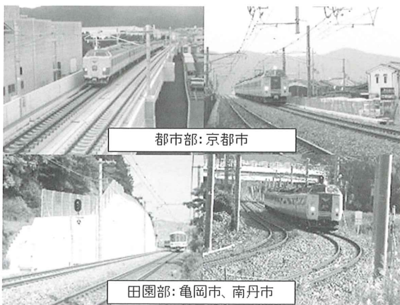
■JR嵯峨野線複線化工事(複線化区間を走行する列車)
